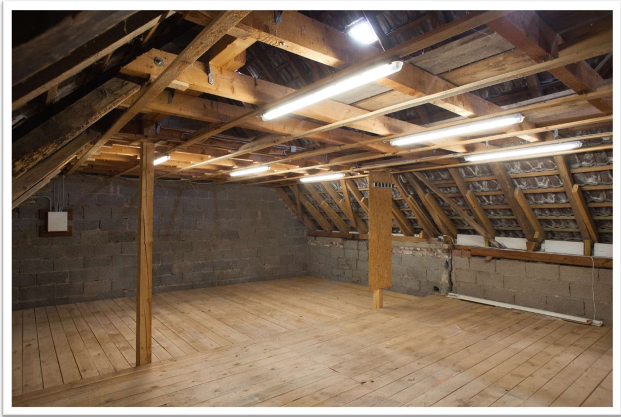
Ausbaureserve im Obergeschoss
