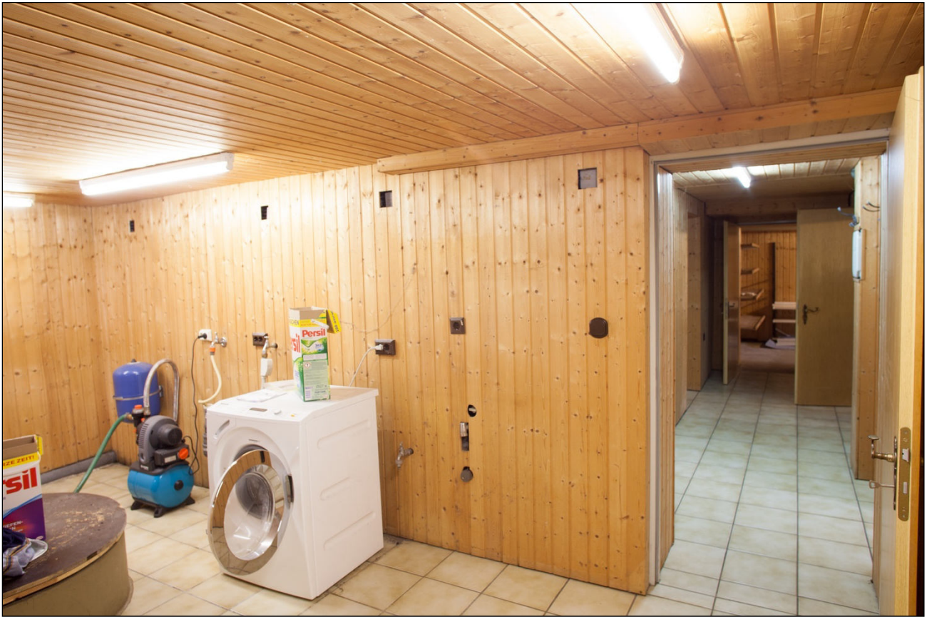
Hauswirtschaftsraum im Keller mit Brunnen
